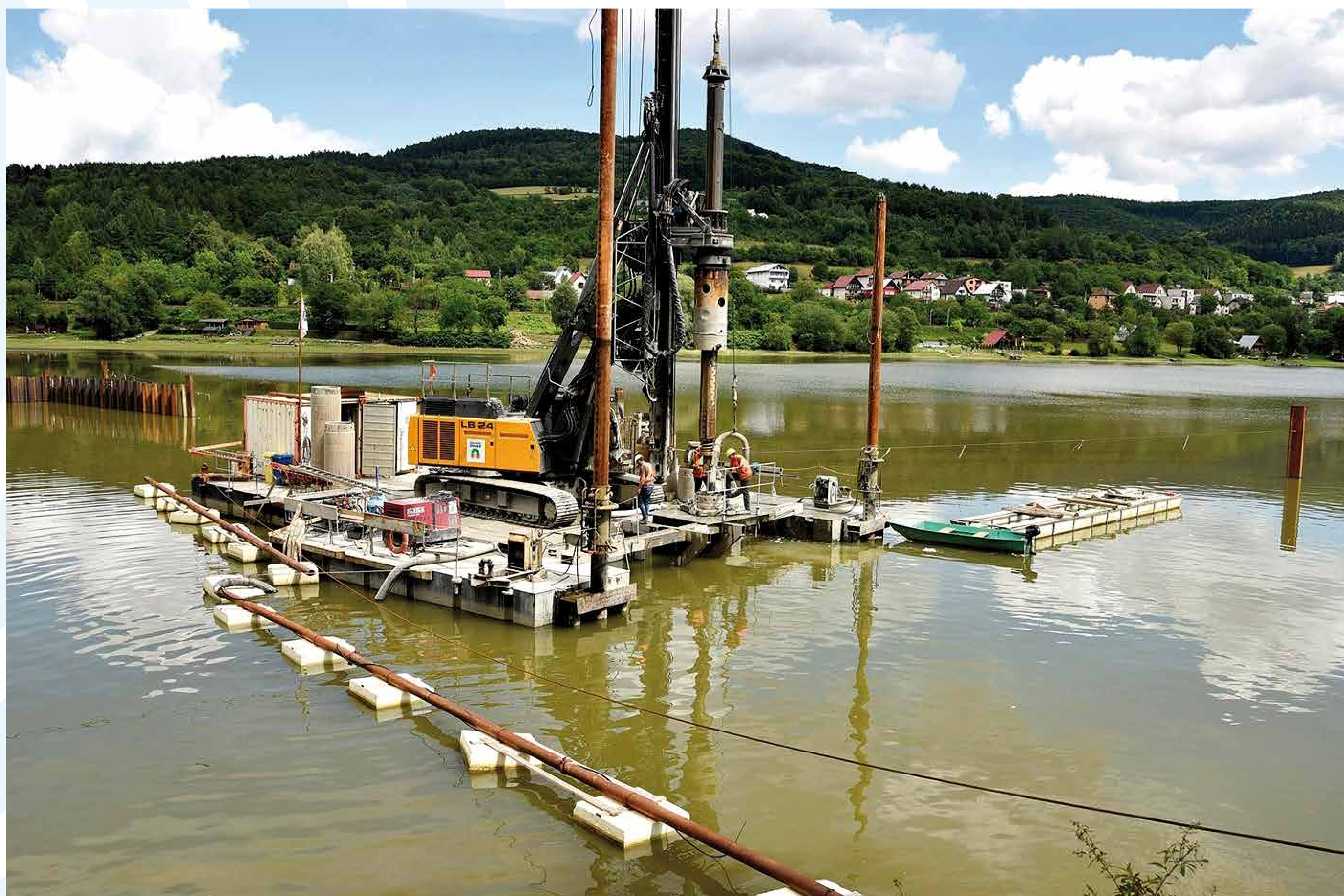
Beranův pilot pro založení železničního mostu – Zaška a Šperger, Zakládání staveb, 2019 Pile driving for the railway bridge pier foundation – Zaška and Šperger, Zakládání staveb company, Prague, 2019
